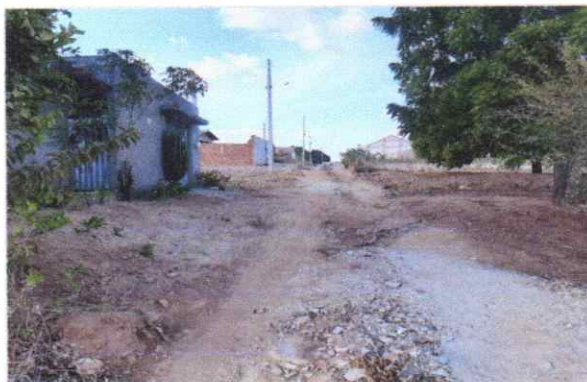
RUA PROJETADA 17 (GINÁSIO) – FINAL 24 M 614882.11 m E / 9323635.68 m S
