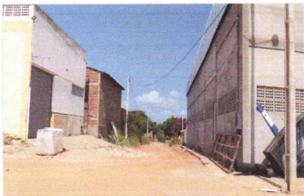
RUA PROJETADA III, INÍCIO 24 M 616020.02 m E / 9324218.74m S
